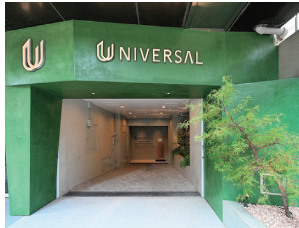
日本橋支店外観
